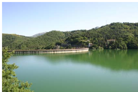
Diga del Pertusillo – Livello di massimo invaso
